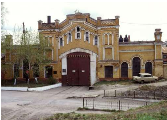
Рис. 4. Здание механического цеха 1870 г.
